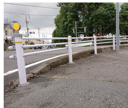
⑧ガードレール新設により歩行者の安全確保
