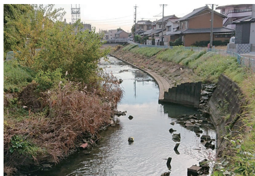
③野府川割田橋付近のみ未整備
